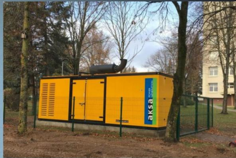
Pav. vieta generatoriui parinkta toliau nuo pastatų grūties zonos, bet nėra apsaugos nuo kinetinio poveikio
