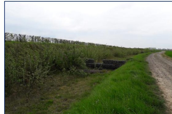
Fossé à redents à Estreux
